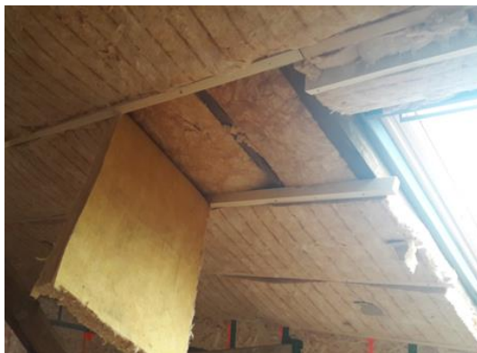
Abbildung 1 - Dokumentation Dämmung Dach
