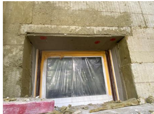
Abbildung 2 - Dokumentation Dämmung Außenwand
